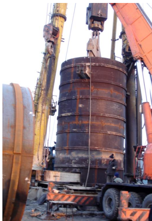
Рисунок 3. Монтаж колонны труб на устье скважины
